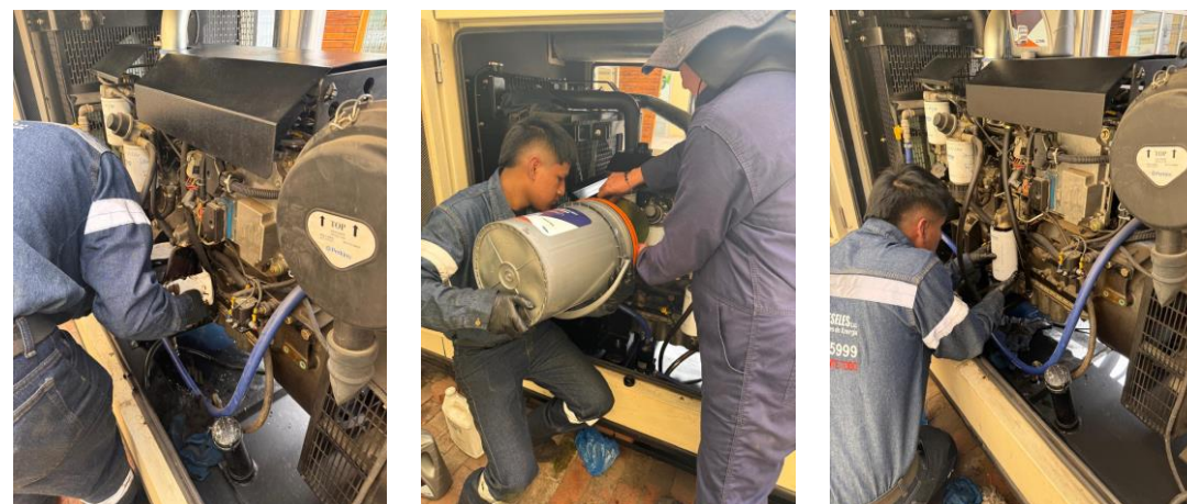
Mantenimiento preventivo Planta eléctrica.
