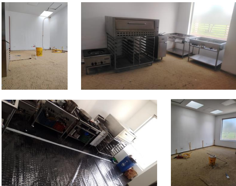
Adecuaciones cocina provisional del CCV.
