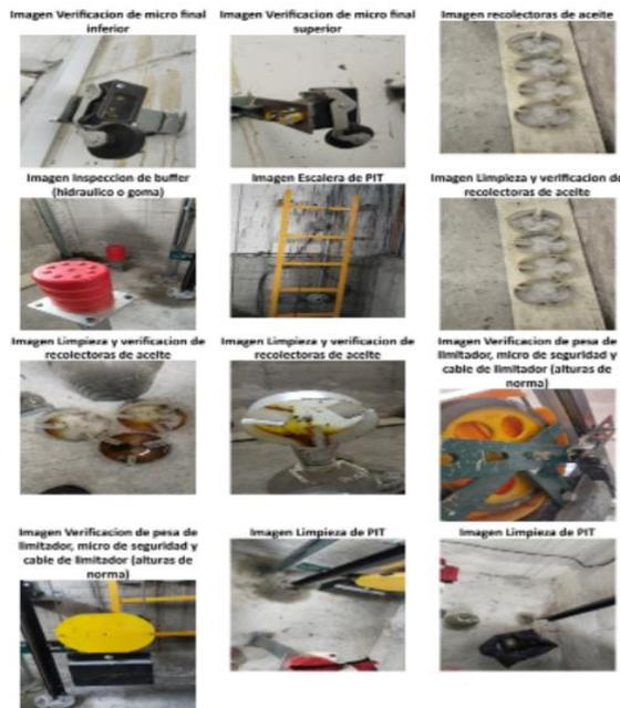
Con el objetivo de garantizar la seguridad de los funcionarios y asegurar el correcto funcionamiento del **ascensor ubicado en la sede norte** de la CCT, durante el mes de mayo se realizó un **mantenimiento técnico preventivo**. Este incluyó la limpieza general del sistema, ajustes mecánicos y, de manera preventiva, el cambio de la guaya del ascensor, medida orientada a evitar posibles fallas y prolongar la vida útil del equipo.
