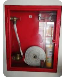
Instalación de mangueras en los 5 gabinetes ubicados en el centro de convenciones para atención de emergencias (09 de julio)
