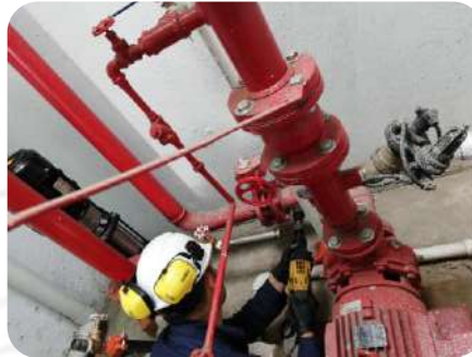
Suministro e instalación de la bomba del centro de convenciones (4 de julio)
