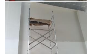
Reparación y pintura entrada norte.
