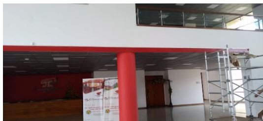
Pintura de rejilla lobby principal y pintura de columnas.
