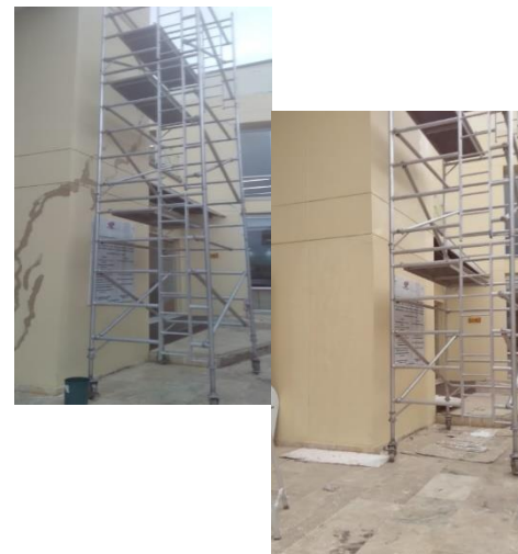
Pintura Lobby parte alta
