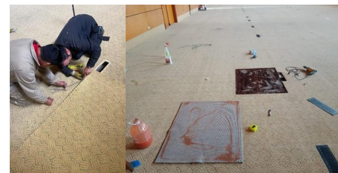
Mantenimiento y reparación de tapete salón 3.
