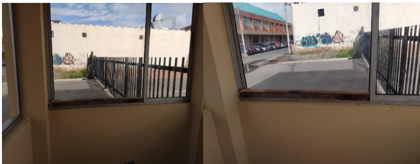
Mantenimiento general y pintura garita parqueadero oriental.
