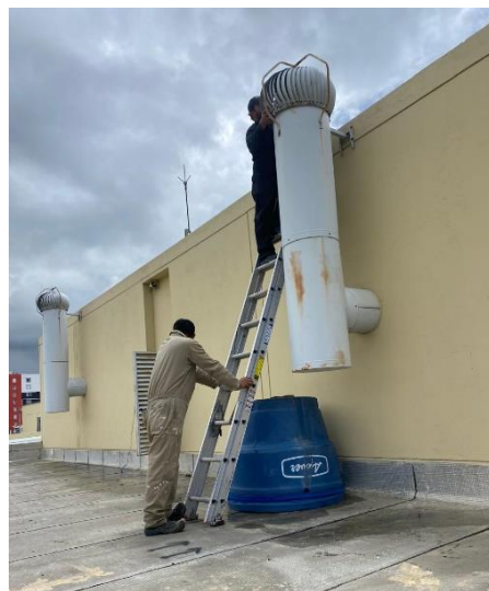
Mantenimiento ductos de ventilación.
